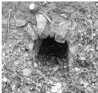
débouché semi enterré d'une galerie de captage vers Balmont
