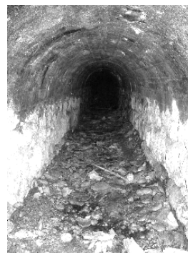
galerie de captage alimentant le moulin de Balmont
